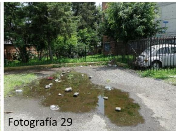
Figura F.1.5.3. Fotografías que muestran los hundimientos en presentados en la barda perimetral y en el estacionamiento.
