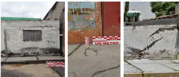
Figura 5. Daños observados en viviendas de mampostería afectadas por grietas en el suelo
