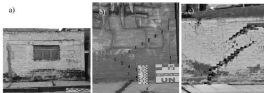
Figura 2. Daños observados en viviendas de mampostería afectadas por grietas en el suelo
