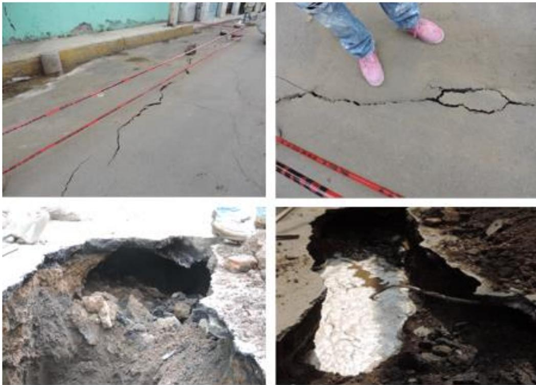
Figura C.33. Aspecto de las grietas y socavón detectado en julio de 2020.
