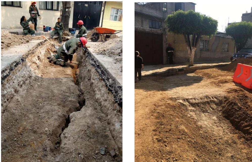
Fig. 3.10.2 Construcción de una caja disipadora
