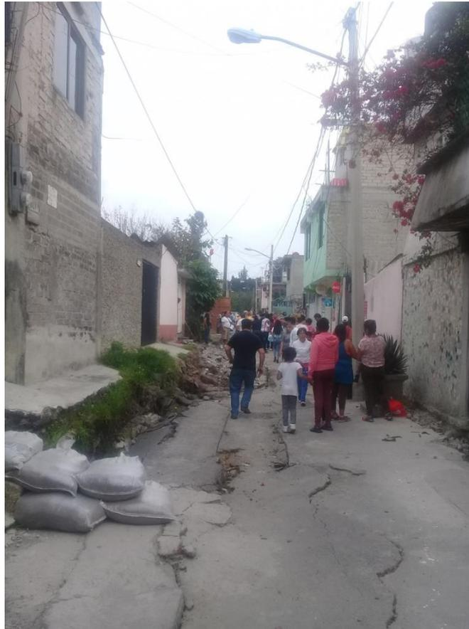
Fig. 3.7.1 Condiciones extremas de agrietamiento que justifican reubicación.
